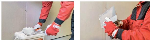
Après cette manipulation, remplissez le joint à l'aide d'un couteau à enduire en travers joint (de droite à gauche puis de gauche à droite) puis avec un couteau à enduire plus large (ou lisseuse) lissez dans le sens du joint et retirez l'excès de matière.
