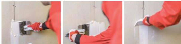
Le joint traité avec PENOSIL Jointaplac 650 peut être poncé, enduit et peint après un séchage de 4-6 heures.
