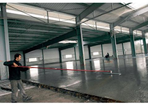
Le manche en aluminium (très léger) se clipse sur la rotule fixée au plateau et par simple rotation de ce manche ❷, on règle et modifie l'angle du plateau : gain de temps et confort de travail assurés. La rotule est démontable et peut être positionnée à 90° ❸ pour une utilisation rapprochée.
