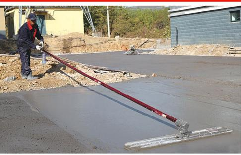
La Lissarde est utilisée pour aplanir le béton et faire disparaître ses imperfections. La taloche sert à «fermer» la surface d'un béton avant de le lisser (*le poids plus équilibré qu'une lissarde acier permet un meilleur écrasement du béton*). Profilé légèrement bombé ❶ pour une glisse parfaite. 2 bouts arrondis : le lissage est parfait sans aucune trace.
