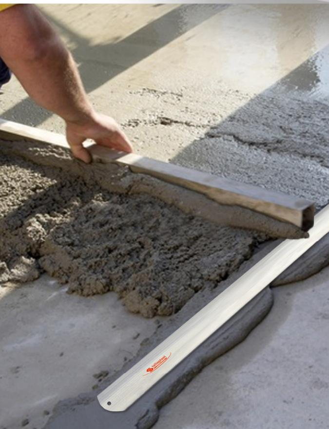
**Protège la surface des guides de chape en mortier, facilite le déplacement de la règle lors du tirage de la chape pour un résultat rapide, précis et propre.**
